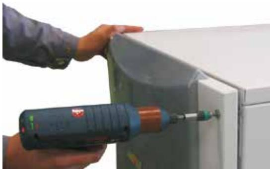
Extraer la parte de revestimiento «Arriba» hacia delante y retirarla
